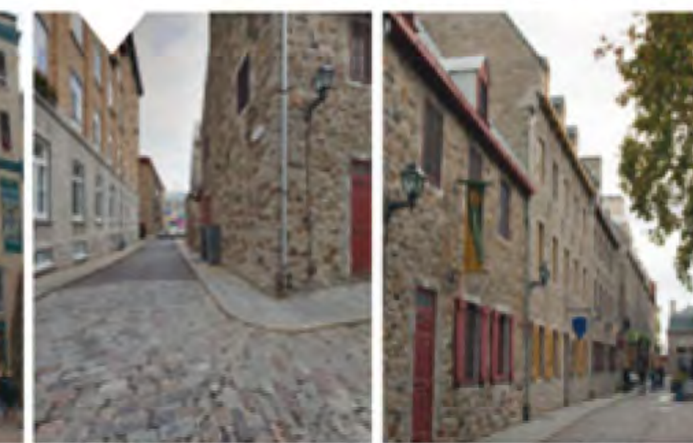
5-1 Quartier de transition 5-2 Rue Saint-Pierre, côté sud 5-3 Écoulement des eaux usées
